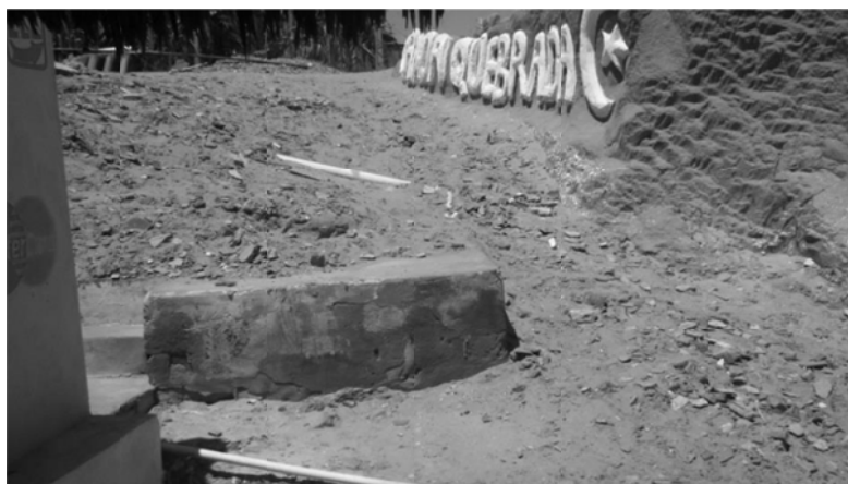
Figura 02: Fossa séptica encontrada em uma barraca
