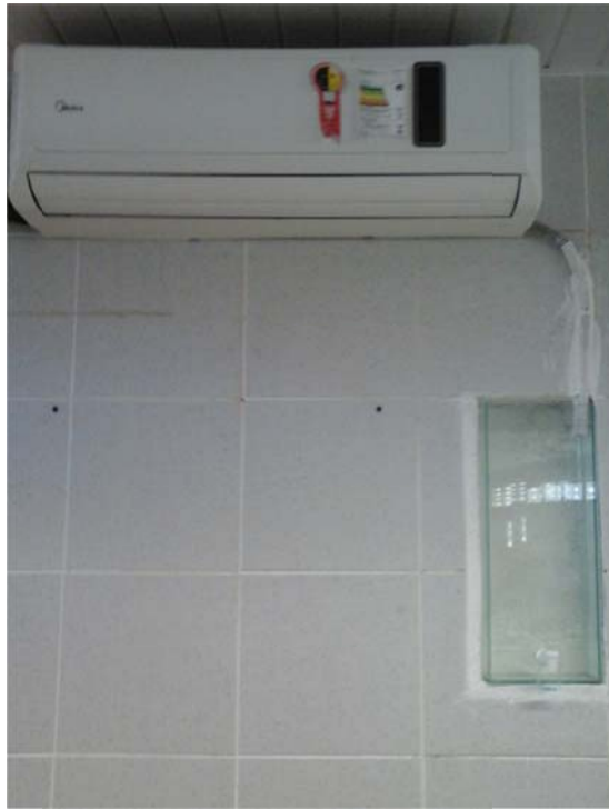
Figura 4. Reservatório de vidro (50,8cm x 20,8cm x 7,8cm) desenvolvido para armazenar a água condensada do ar condicionado Split durante uma jornada de trabalho no laboratório de Química.
