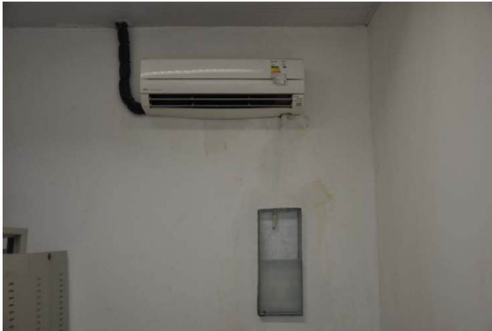
Figura 3. Reservatório de vidro (50,8cm x 20,8cm x 7,8cm) desenvolvido para armazenar a água condensada do ar condicionado Split durante uma jornada de trabalho na sala de reprografia.
